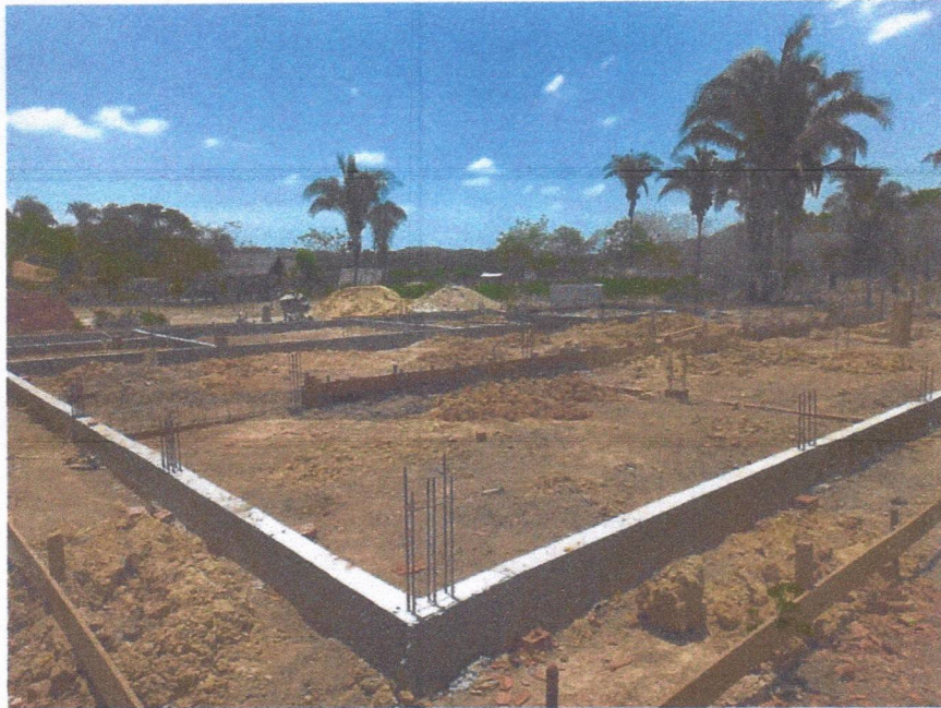
Imagem 7 – Execução da concretagem das vigas baldrames e armação dos arranque dos pilares.
