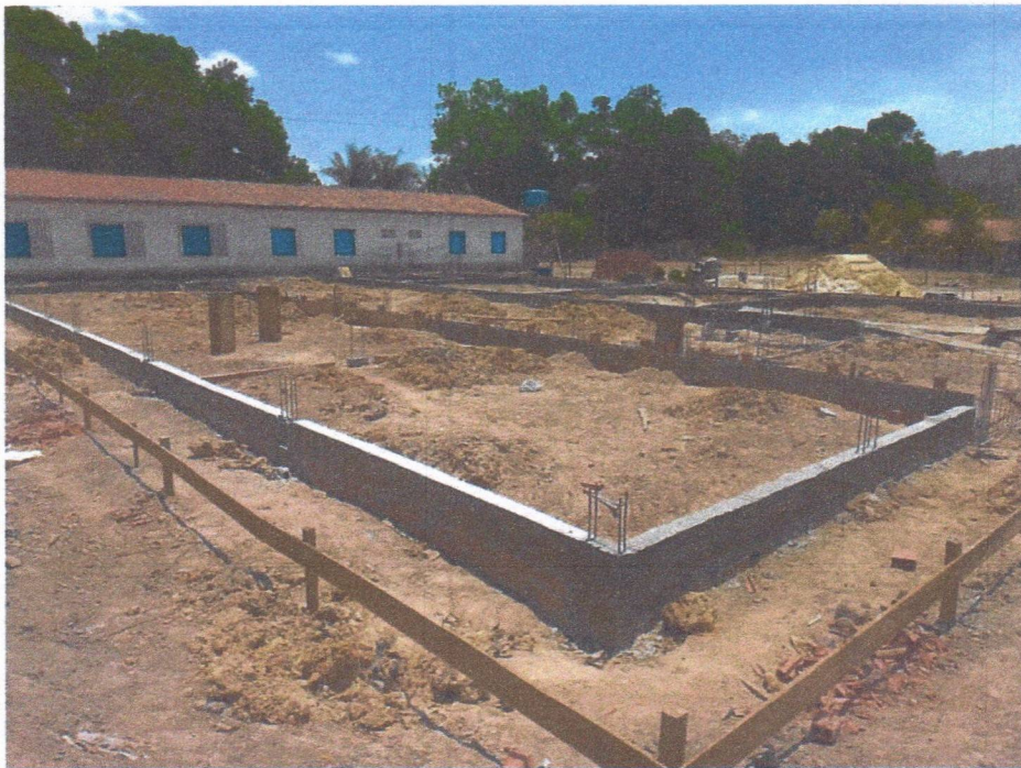
Imagem 4 – Execução das vigas baldrame e arranque dos pilares.
