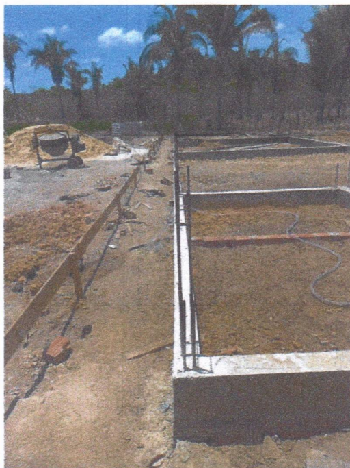
Imagem 6 – Execução da concretagem das vigas baldrame e armação dos arranque dos pilares.
