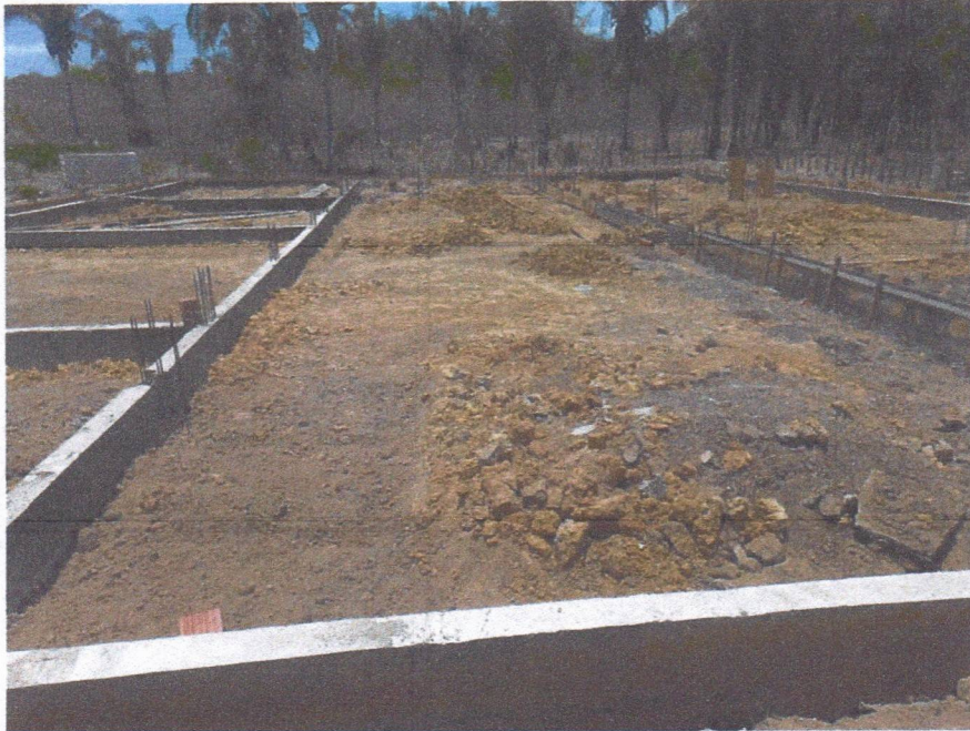
Imagem 3 – Execução das vigas baldrame e arranque dos pilares.
