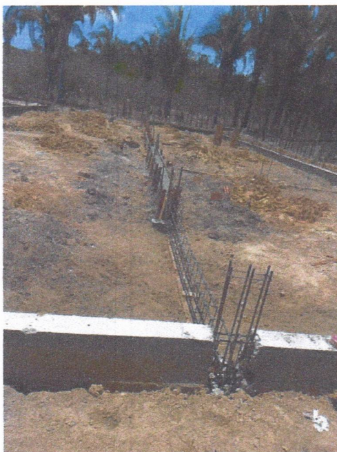
Imagem 2 – Execução das vigas baldrames e arranque dos pilares.
