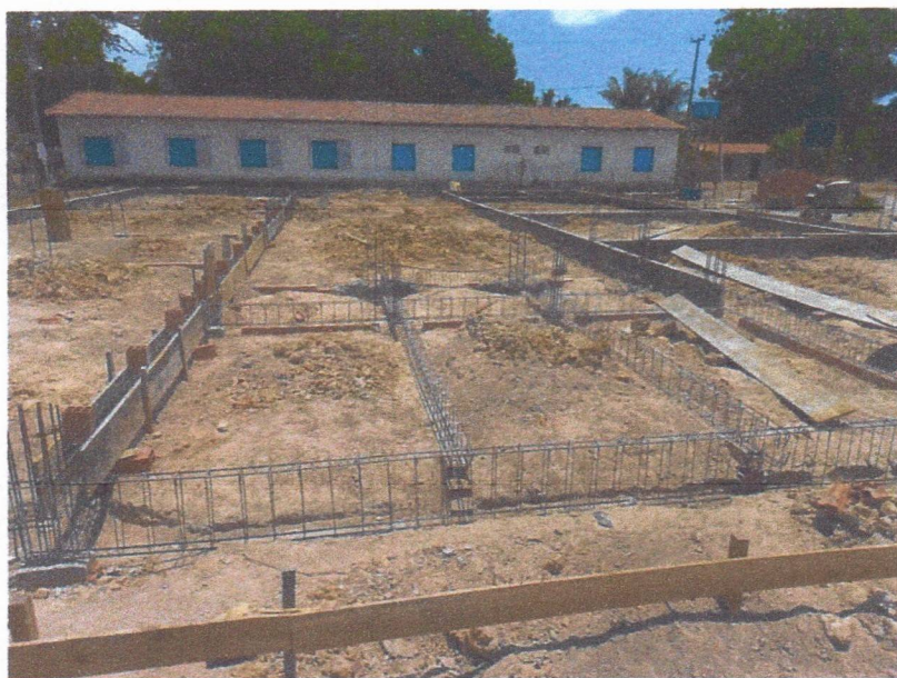
Imagem 1 – Execução das vigas baldrames e arranque dos pilares.
