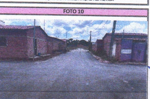
EXECUÇÃO DE PAVIMENTAÇÃO ASFÁLTICA
