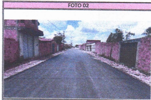
EXECUÇÃO DE PAVIMENTAÇÃO ASFÁLTICA
