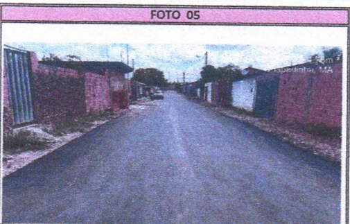
EXECUÇÃO DE PAVIMENTAÇÃO ASFÁLTICA
