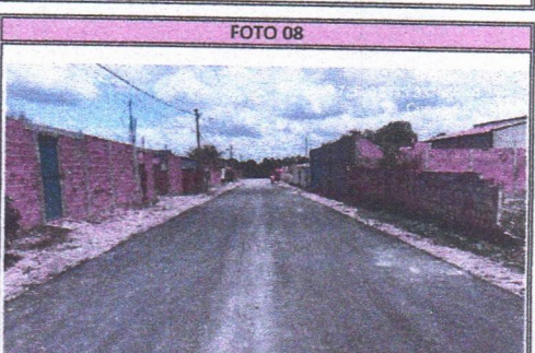
EXECUÇÃO DE PAVIMENTAÇÃO ASFÁLTICA
