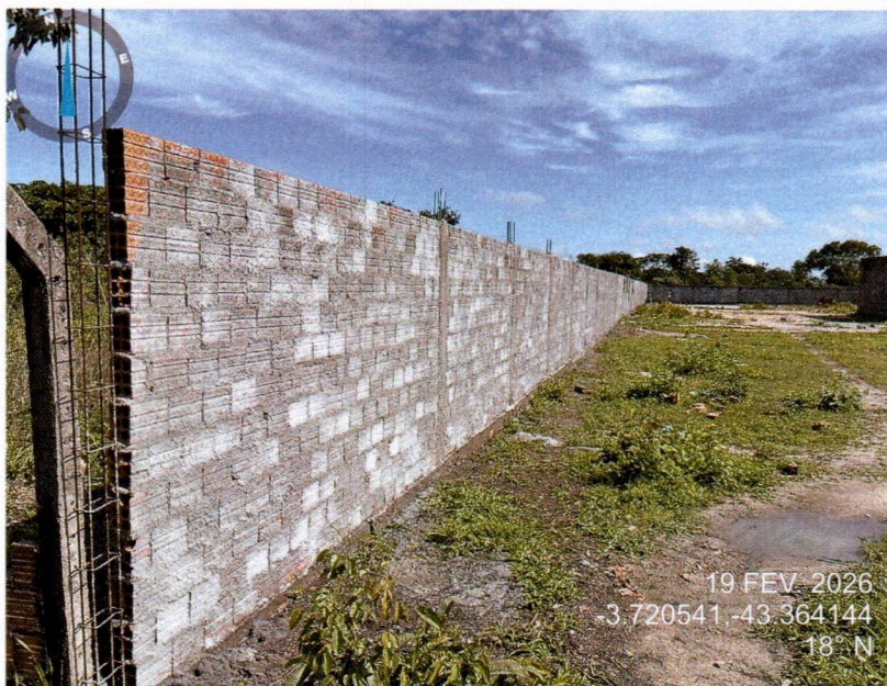
Imagem 10 – Execução de construção de muro
