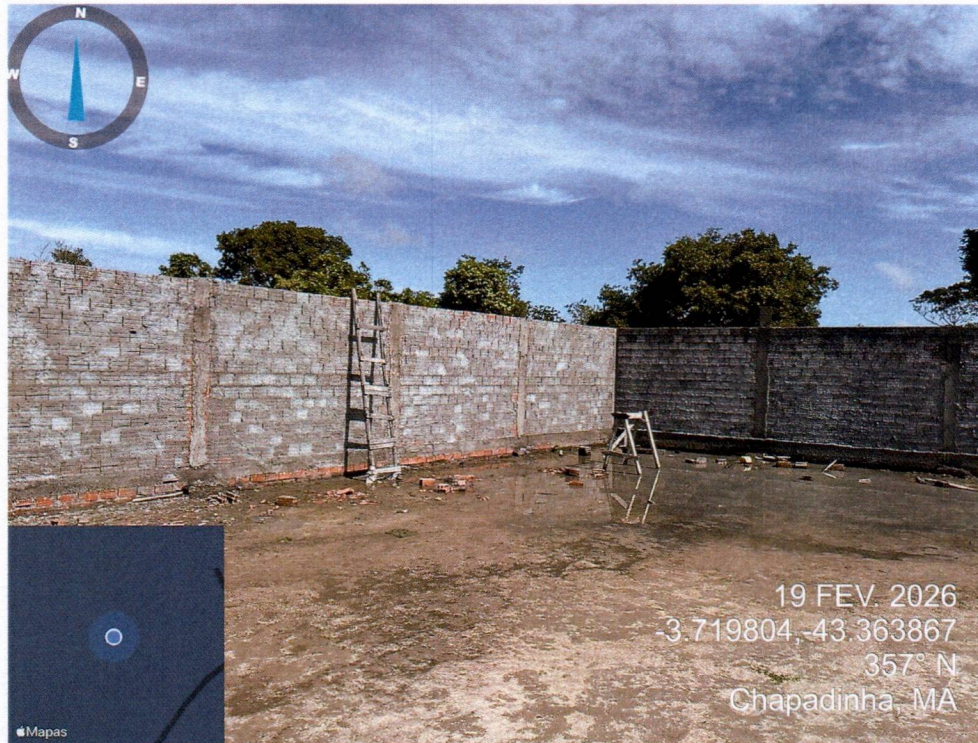
Imagem 08 – Execução de construção de muro
