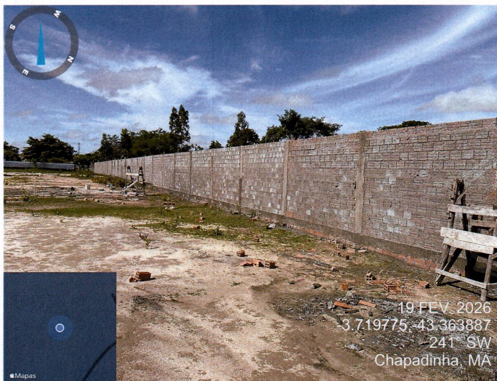
Imagem 07 – Execução de construção de muro
