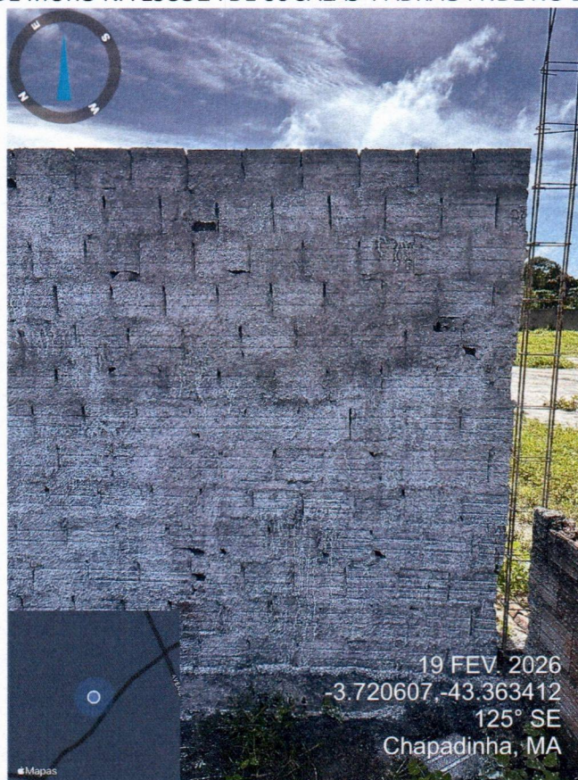
Imagem 01 – Execução de construção de muro
