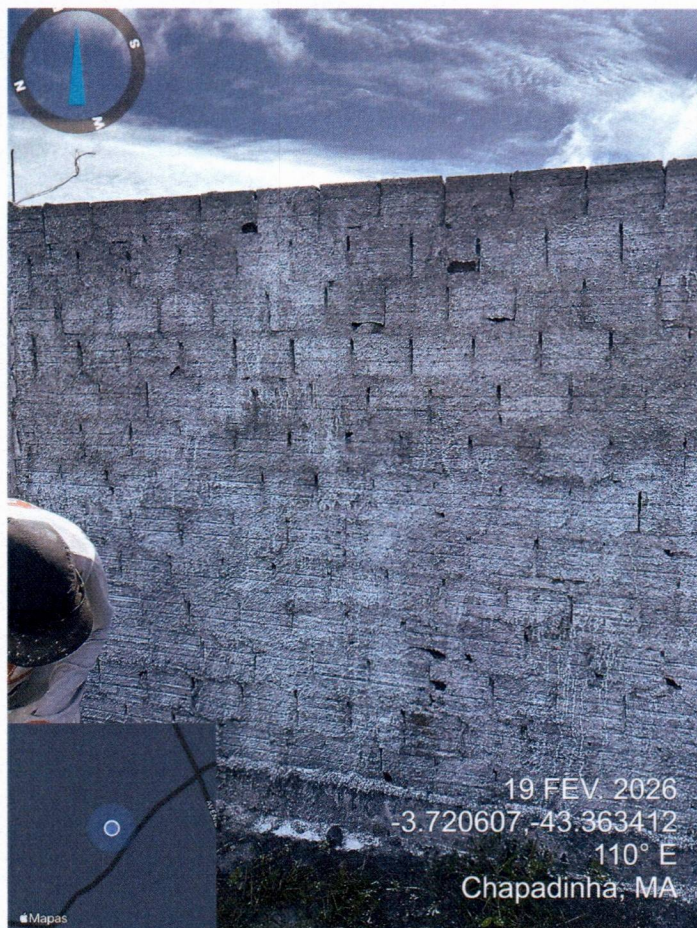
Imagem 06 – Execução de construção de muro
