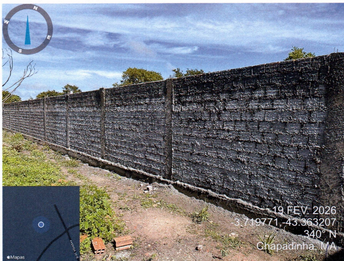
Imagem 05 – Execução de construção de muro
