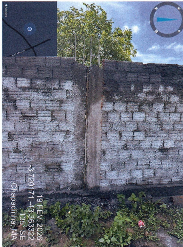
Imagem 02 – Execução de construção de muro
