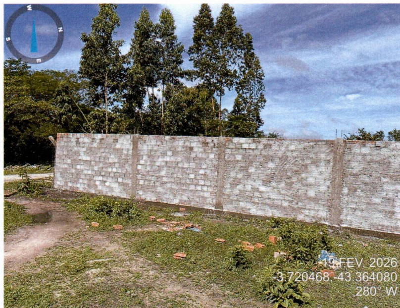
Imagem 09 – Execução de construção de muro
