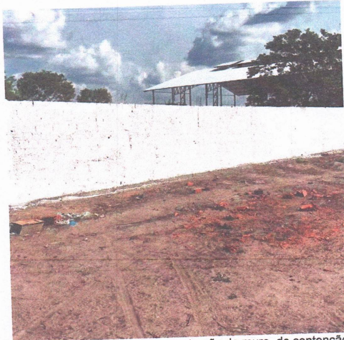
Imagem 08 – Execução de construção de muro de contenção
