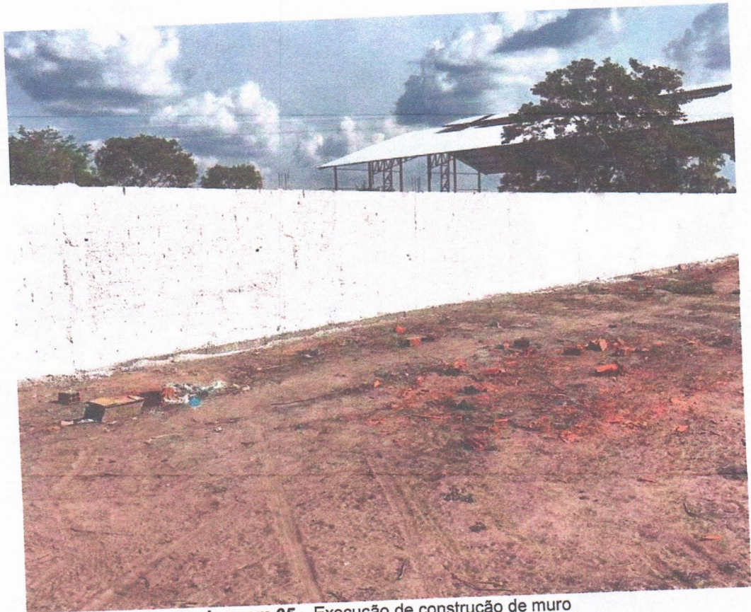
Imagem 04 – Execução de construção de muro
