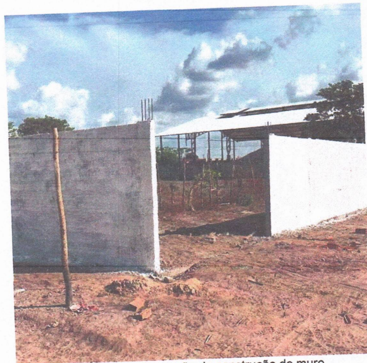
Imagem 07 – Execução de construção de muro
