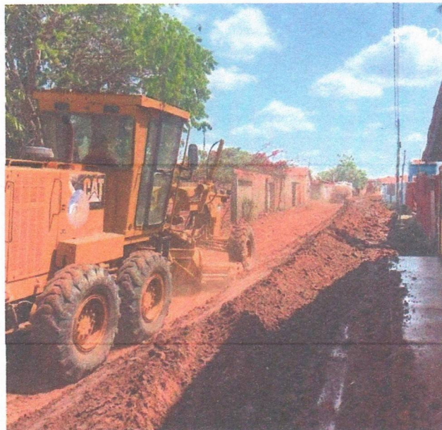
Imagem 02 – Execução dos serviços terraplenagem
