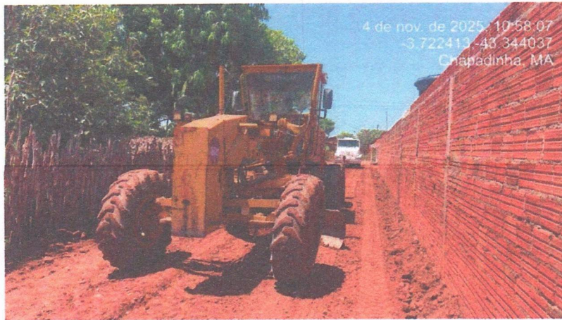
Imagem 01 – Execução dos serviços terraplenagem
