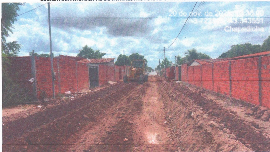
Imagem 9 – Execução dos serviços terraplenagem
