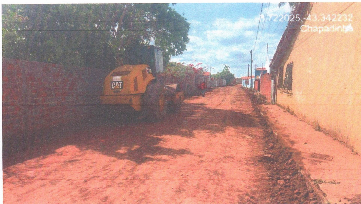
Imagem 04 – Execução dos serviços terraplenagem
