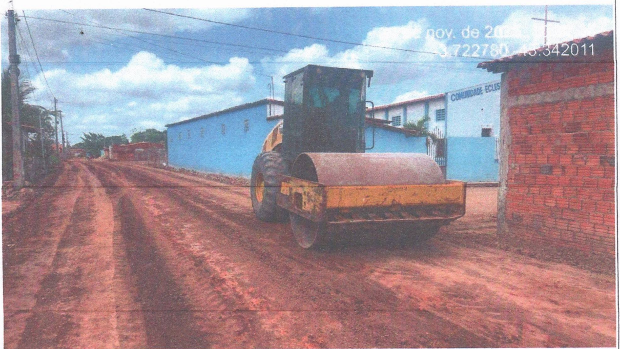
Imagem 8 – Execução dos serviços terraplenagem
