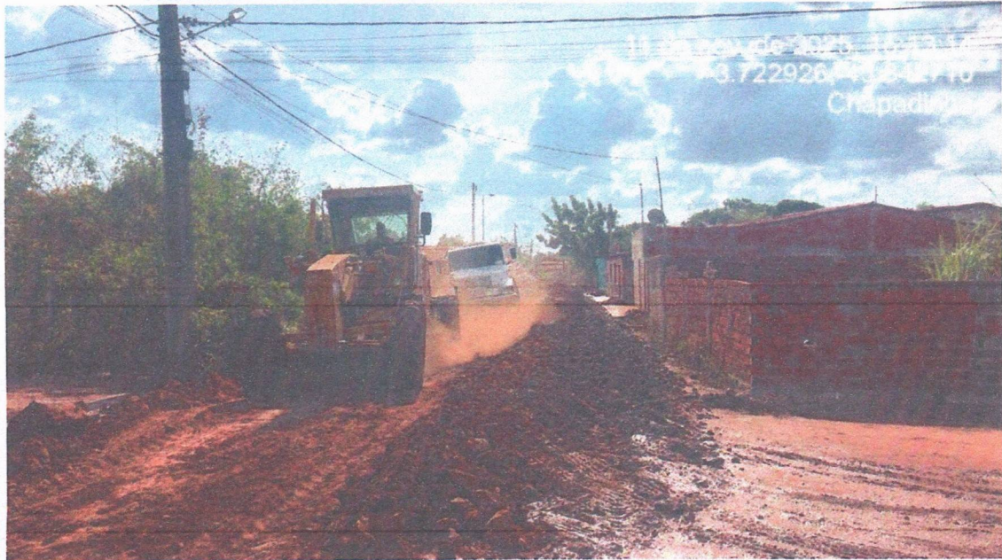
Imagem 05 – Execução dos serviços terraplenagem
