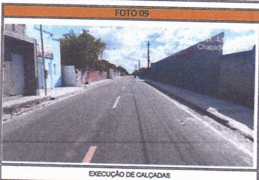
EXECUÇÃO DE CALÇADAS
