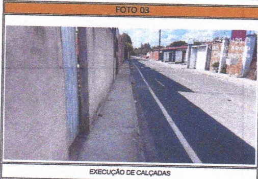
EXECUÇÃO DE CALÇADAS
