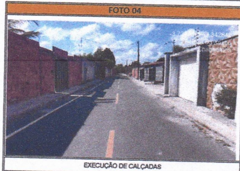
EXECUÇÃO DE CALÇADAS
