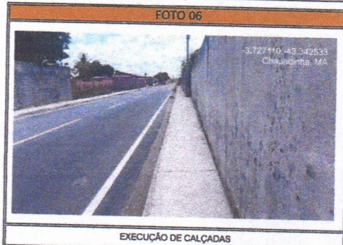
EXECUÇÃO DE CALÇADAS
