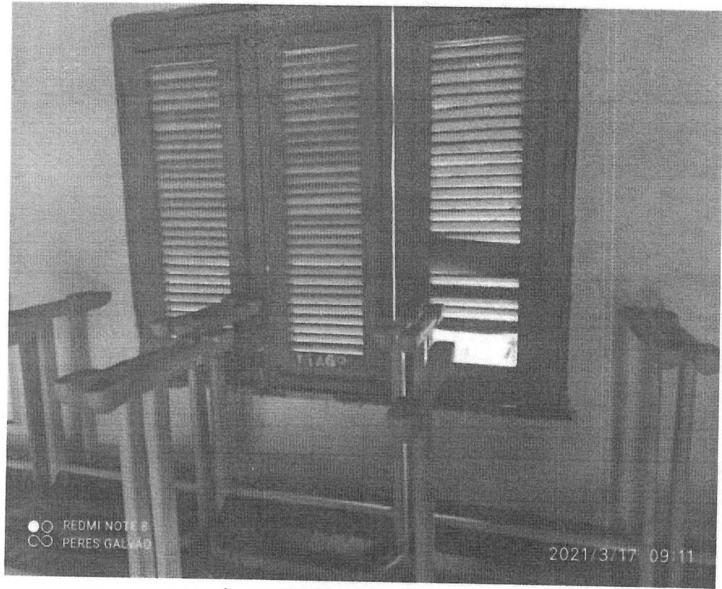
imagem 7 - Pintura de esquadria
