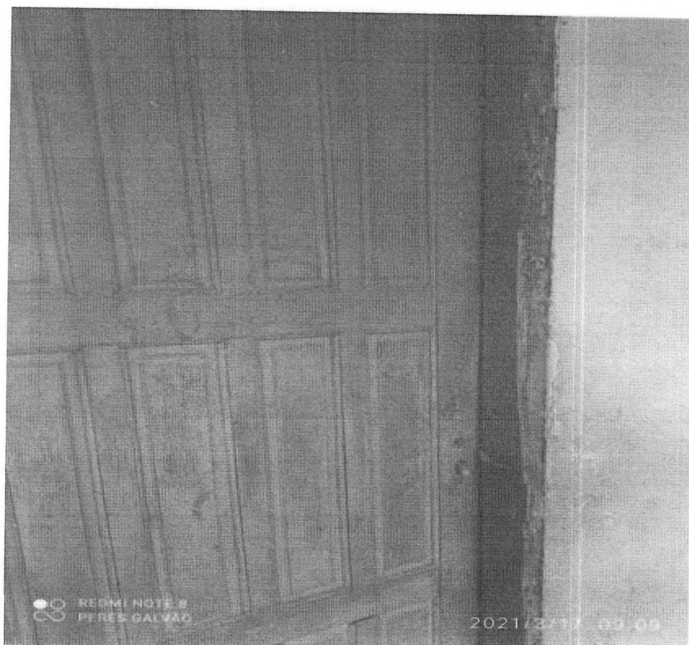
imagem 6 - Reparação e pintura de esquadria
