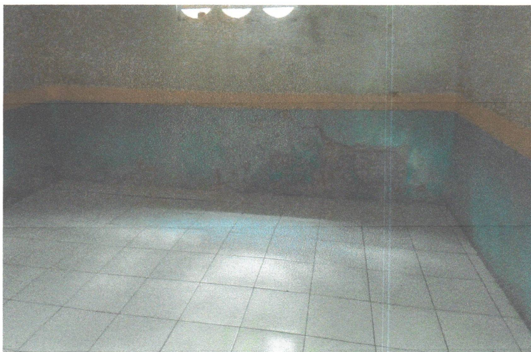
imagem 10 - Chapisco, reboco, e pintura danificados
