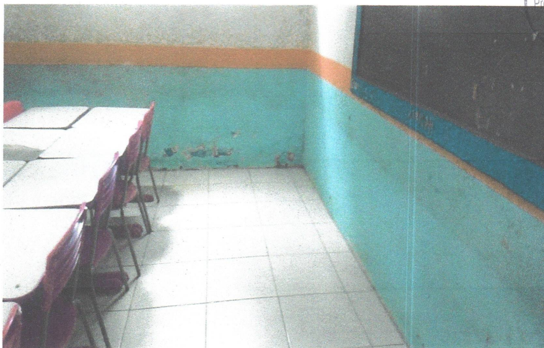
imagem 13 - Chapisco, reboco, e pintura danificados
