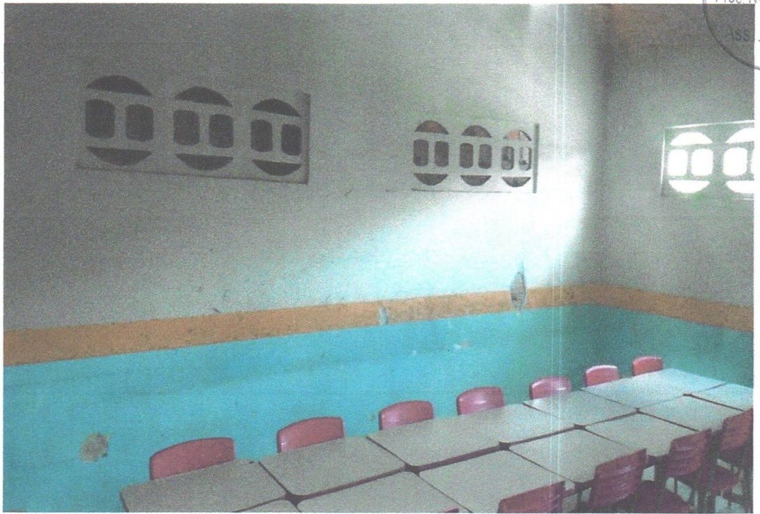
imagem 11 - Chapisco, reboco, e pintura danificados
