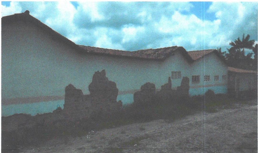
imagem 1 - Chapisco, reboco, e pintura danificados
