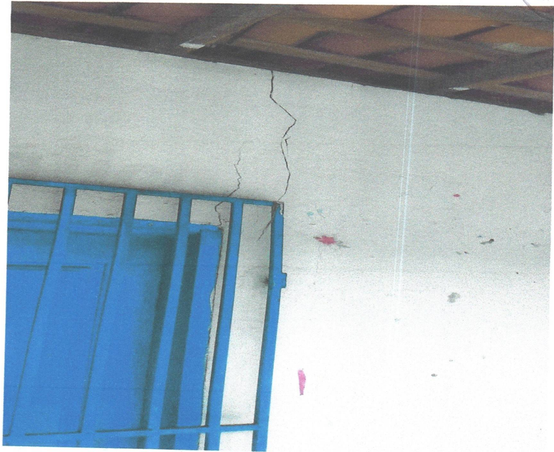
imagem 37 - Rachadura na parede
