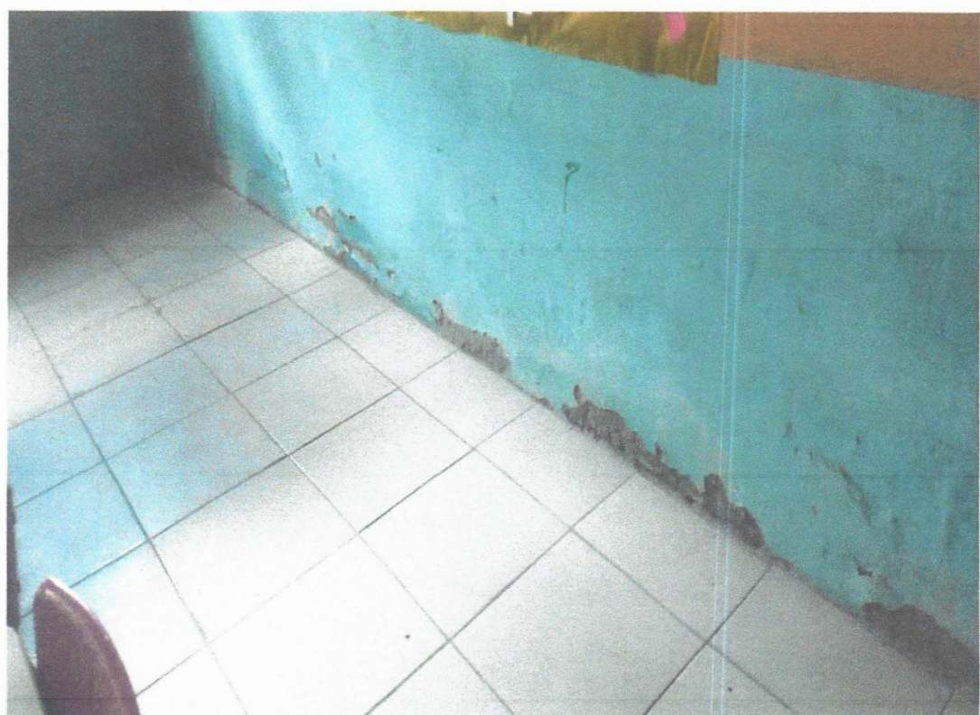
imagem 16 - Chapisco, reboco, e pintura danificados
