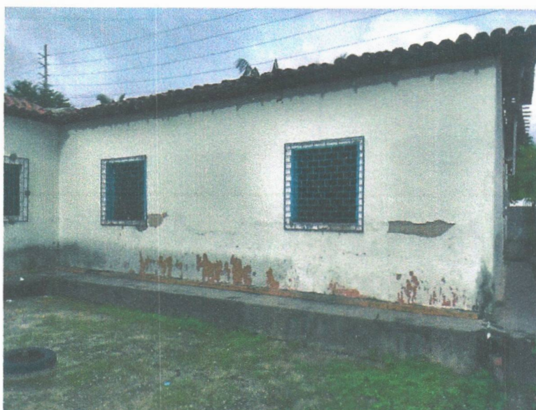
Imagem 13 – Pintura e telhado danificados
