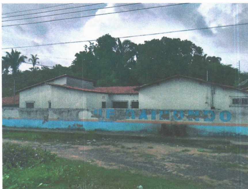
Imagem 2 – Pintura muro externo danificada
