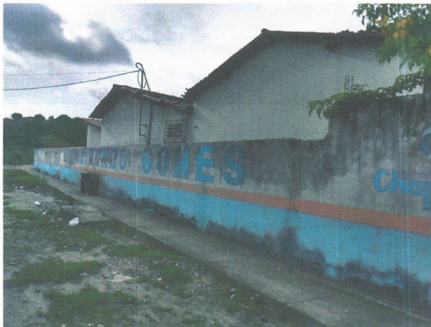
Imagem 1 – Pintura muro externo danificada
