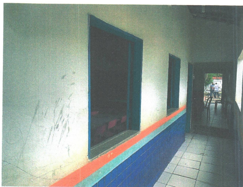
Imagem 26 – Pintura interna danificada
