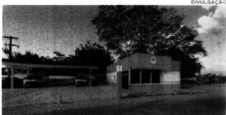
Base descentralizada do Samu, em Santa Inês
