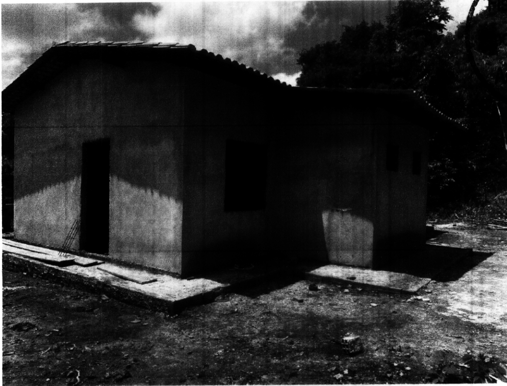
Foto 04 – inclusão de serviços: chapisco, reboco, esquadria e calçada
