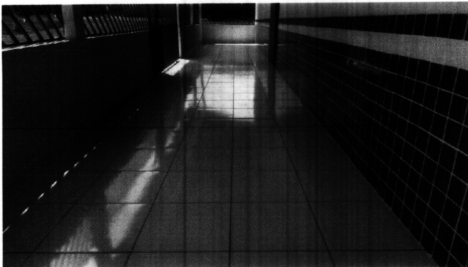
Foto 08 – Piso Cerâmico área da varanda
