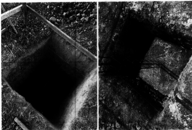
Foto 02 – escavação dos blocos de fundação dos serviços do muro de proteção e varanda
