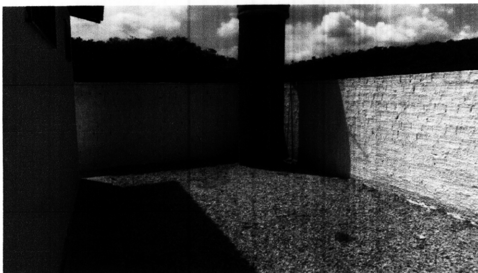
Foto 09 – muro de proteção da Unidade Escolar
