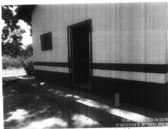
Imagem 04: pintura do piso (calçada)
