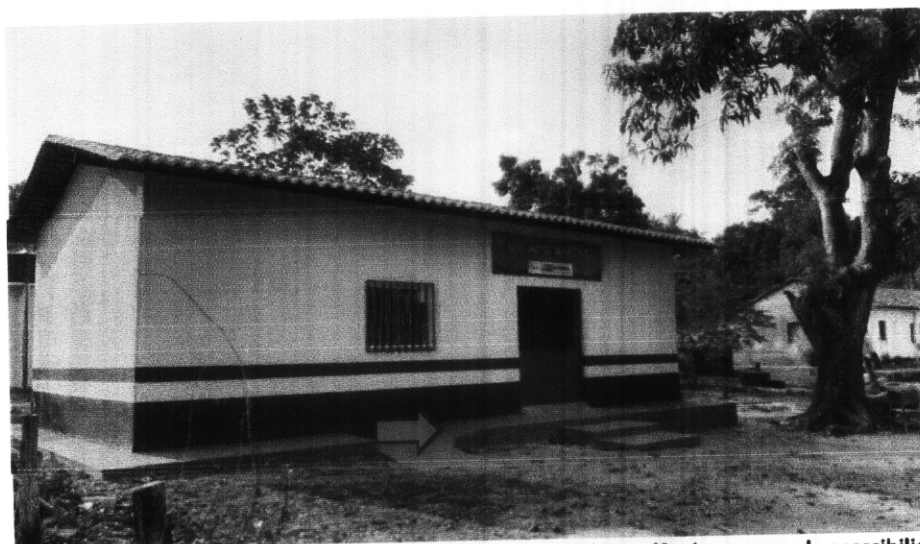
Imagem 03: construção da escola básica de uma sala e demais dependências, rampa de acessibilidade.
